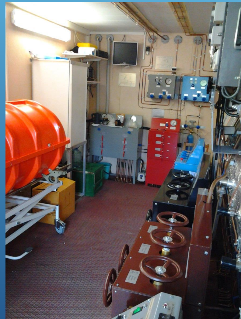
Вид внутри (от входа)
